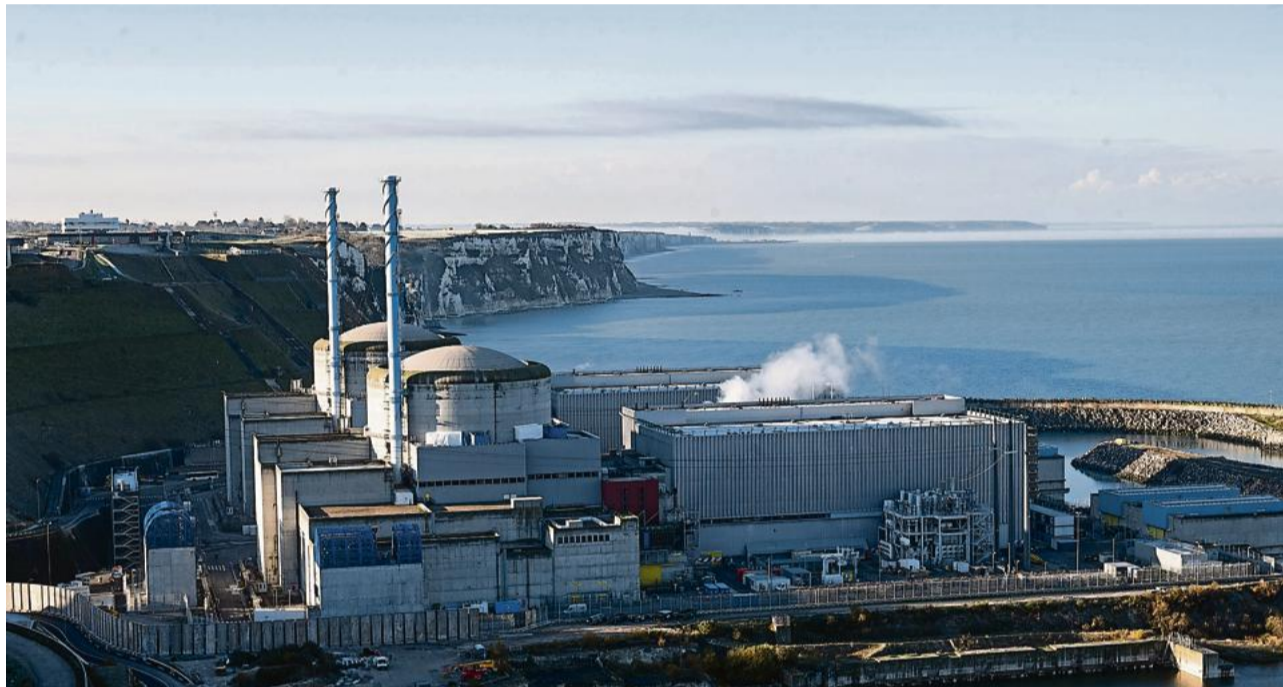
Les travaux préparatoires au chantier EPR2 ont commencé cet été dans la centrale de Penly. Photo Eric Tschäen/RÉA
